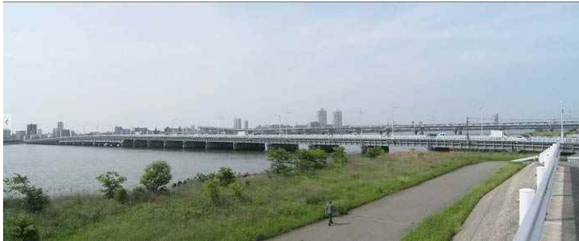
全景(上流から)
