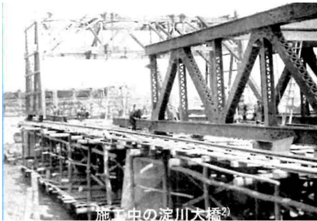
施工中の淀川大橋 2)
