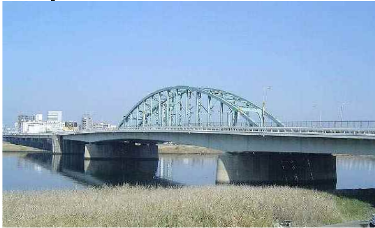
ランガー桁部
